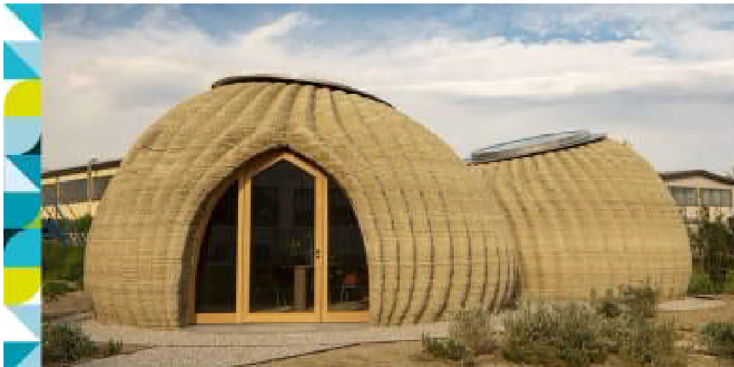
Prototypes d'habitation en terre crue imprimés en 3D
